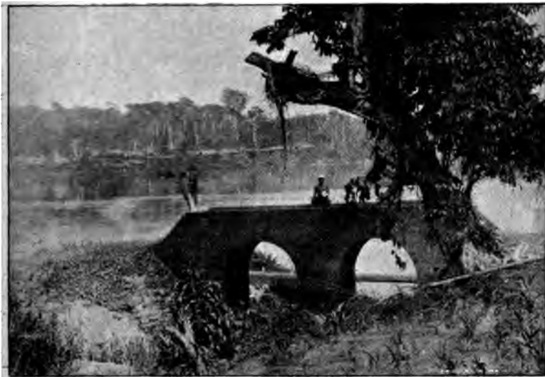
PONT EN BRIQUES SUR UNE ROUTE DU HAUT-CONGO
